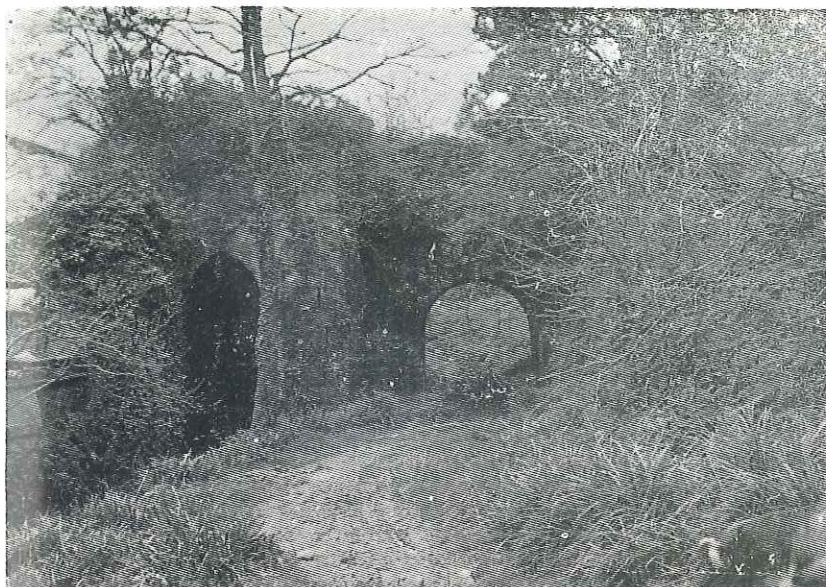
Ruinas en la actualidad de la parte del canal y accionamiento hidráulico de la Ferrería Arrazubía en Aya (Guipúzcoa) y en la que fabricaron los Guilisastis sus famosas anclas.
