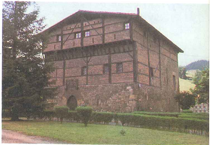
JAUREGUI. Zumarraga, Guipúzcoa. A mediados del s. XV se reconstruyó esta casa torre a partir de la primera planta. Cuna de Miguel López de Legazpi, Adelantado de México y colonizador de las Islas Filipinas.
