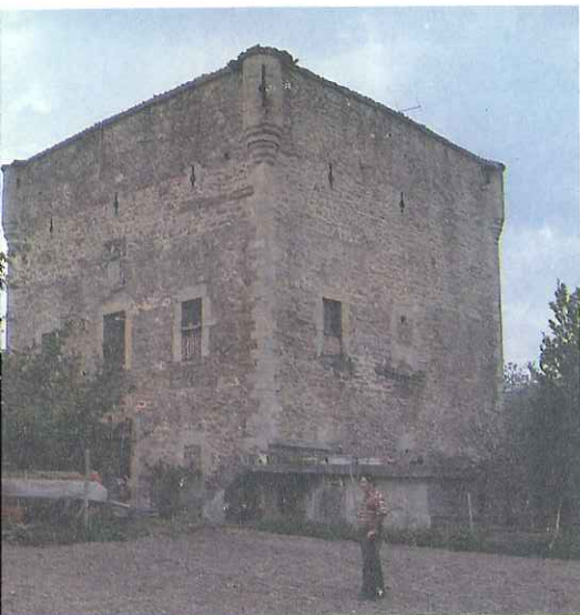
MENDIETA. Arceniega, Alava. Torre defensiva erigida en lugar estratégico. Conserva los garitones, troneras y saeteras propias de este tipo de edificaciones.
