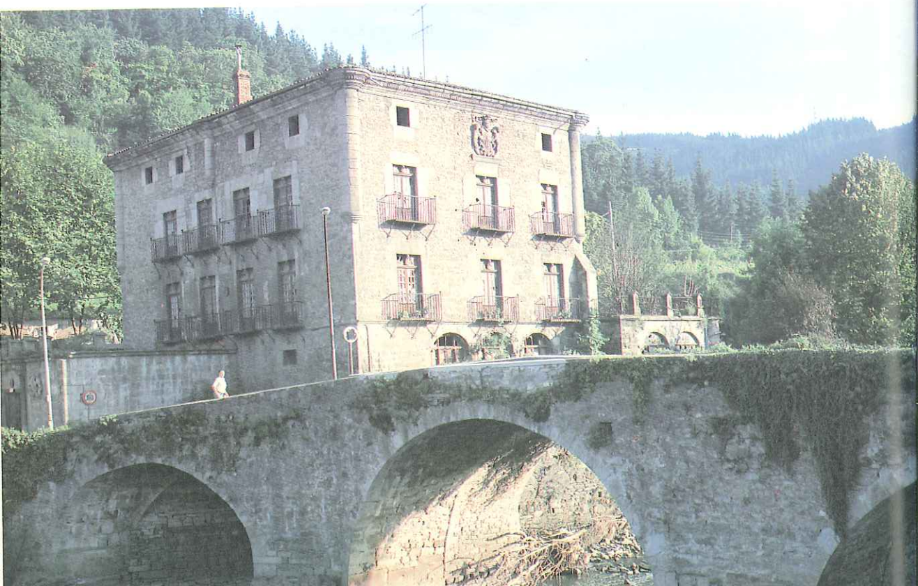
OZAETA. Casa solar de "Parientes Mayores", ubicada en Bergara, Guipúzcoa, a orillas del río Deba.
