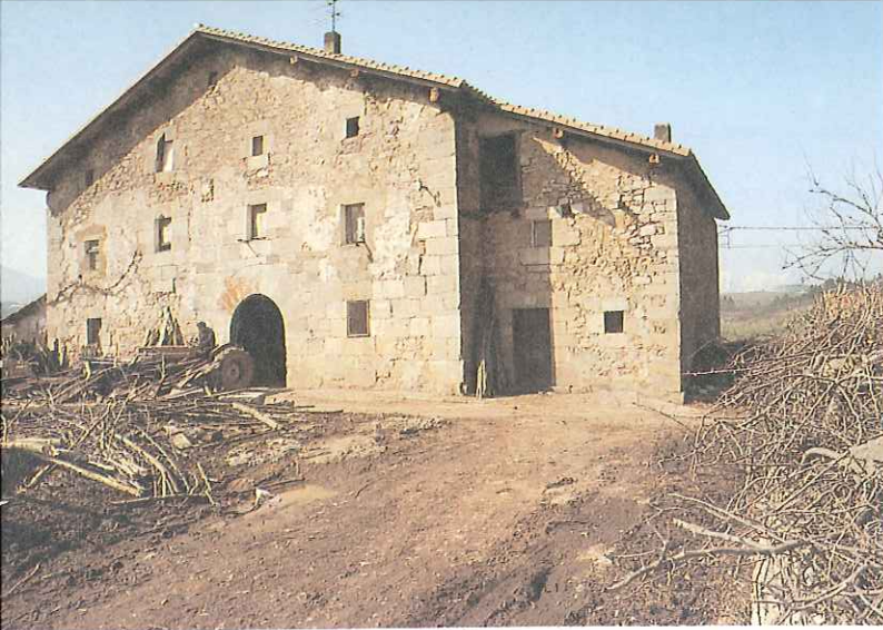
MAISTERRENA. Caserío de sólida construcción en piedra, sin revocar ni blanquear las fachadas. Se halla en Iribas, Navarra.
