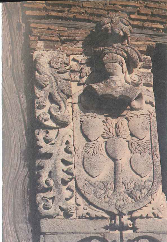
SAGASTA. Blasón del solar localizado en el Consejo alavés de Argomaniz. El edificio se halla en estado ruinoso.
