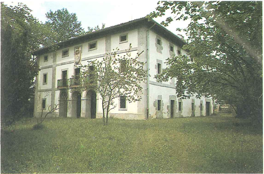
PALACIO. Su nombre es Iriarte. Los nativos le denominan "palacio" por su empaque. Es una mansión compacta, barroca, con esquinales y formeros de sillares calizos en maridaje con los lienzos blanqueados. Tres arcos de medio punto acceden al zaguán, coincidiendo con los balcones. Se ubica en Bidania, Guipúzcoa.
