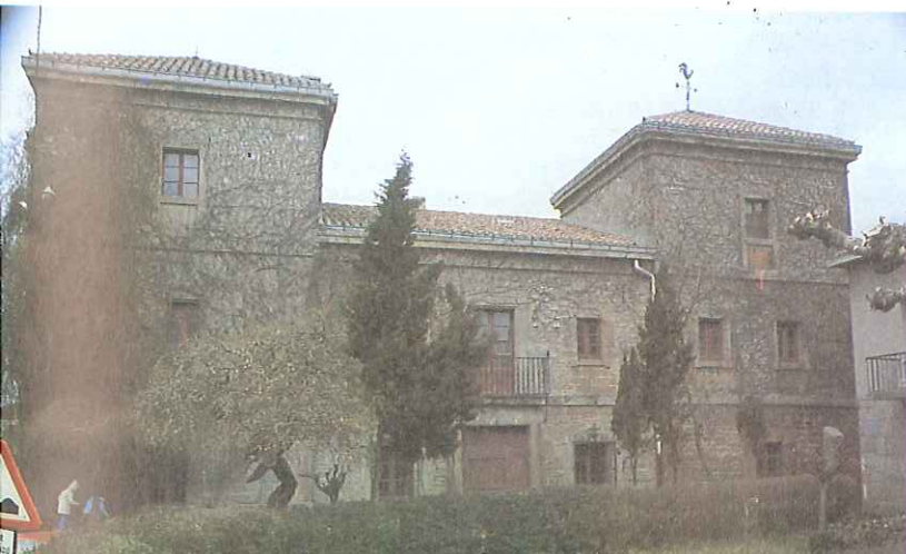
GAMARRA. Palacio de la influyente familia Gamarra, sito en Gamarra Mayor, Alava. De sobria fachada flanqueada por dos torreones romos. Escuadra a la iglesia, que es de su patronazgo.
