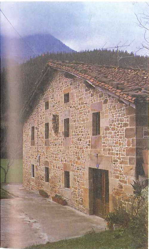
JAUREGUI. Topónimo común en el nomenclator de muchas casas de Euzkadi. En la fotografía, el caserío Jauregui, en Axpe (Achondo), Vizcaya.
