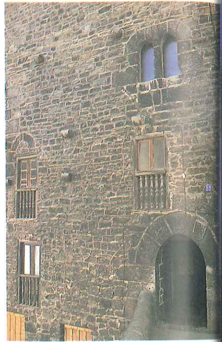
LICONA. Ondarroa, Vizcaya. Fachada principal de la torre de Licona, donde nació Doña María de Licona, madre de San Ignacio de Loyola.
