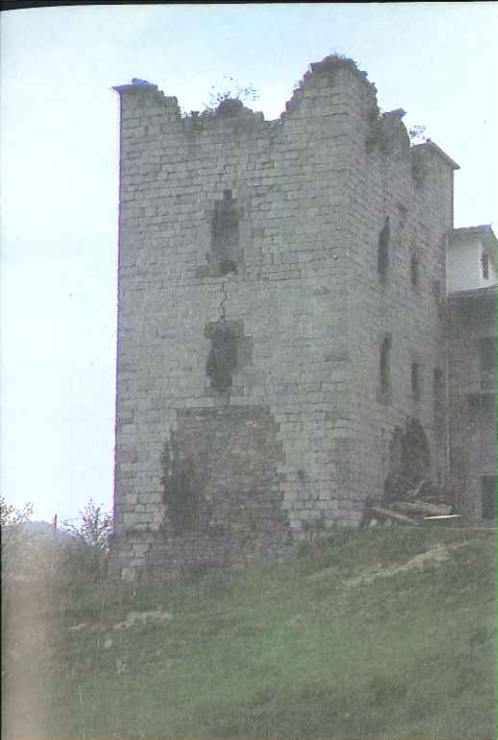
ORIBE. Sojoguti, Alava. Sólida torre medieval construida de sillares. Su severa estampa ha sufrido merma al adosársele otras edificaciones rurales.
