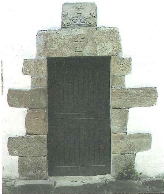
REMENTERIA. Detalle de la puerta construida con sillares de piedra arenisca y graciosas tallas en el arquitrabe.
