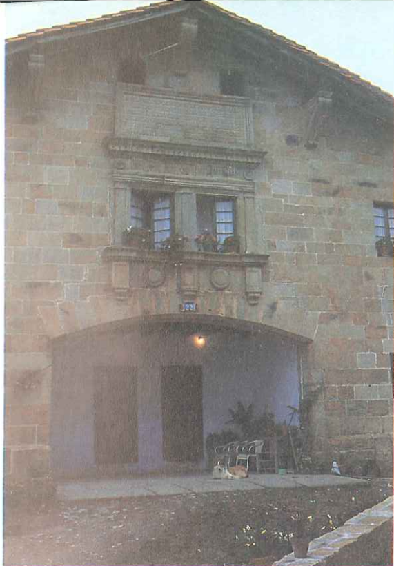
GARAY. En la anteiglesia de su nombre, en Vizcaya. Casa noble con fachada de piedras sillares, zaguán en arco escarzano, escudos heráldicos y placa tallada que da cuenta de las proezas de sus ilustres hijos por tierras de América.
