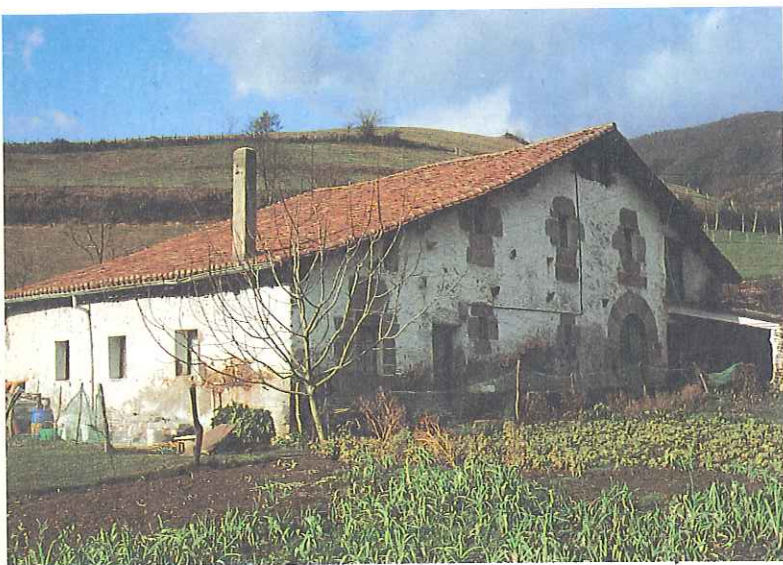
GOYENECHÉ. Casa de labranza de la aldea de Eldúa, cerca de Tolosa, en Guipúzcoa. La etimología señala su ubicación en lo más elevado del conjunto urbano.
