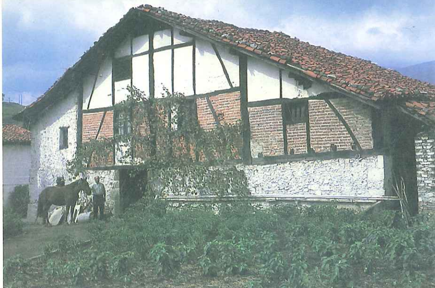
ARANA. Casa de labranza de Ibarra, Guipúzcoa, Prototípico de construcción rural vasca con tejado a dos aguas, frontón a la fachada principal, entramado de vigas y lienzos cuajados de ladrillos.
