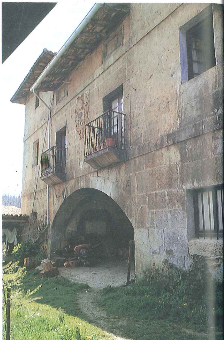
ARANA. Casa palacio de Izpazter, Vizcaya. Fachada de piedra sillar, arco escarzano y escudo de armas.
