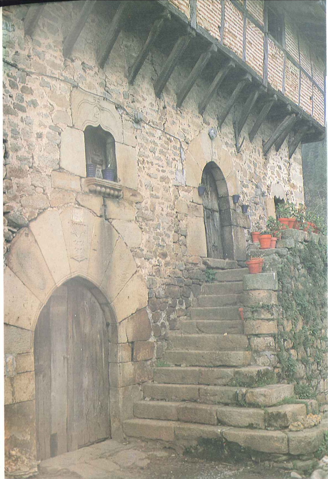
ARANGUREN. Casa torre de indiscutible singularidad, sita en Orozco, Vizcaya. Sus características arquitectónicas y su historia apuntan a una torre medieval, arco ojival de acceso, escalera de patín, ventanales conopiales y otros detalles.
