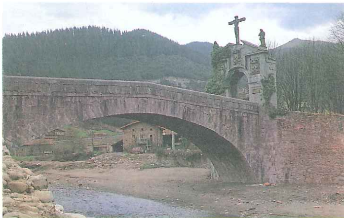
ARETA. Atrevido puente de arco carpanel y sillares, construido en 1741. Se acerca al mismo por un portón de piedra coronado por el grupo escultórico del Calvario. El río Nervión discurre bajo este monumento de Areta, Alava.
