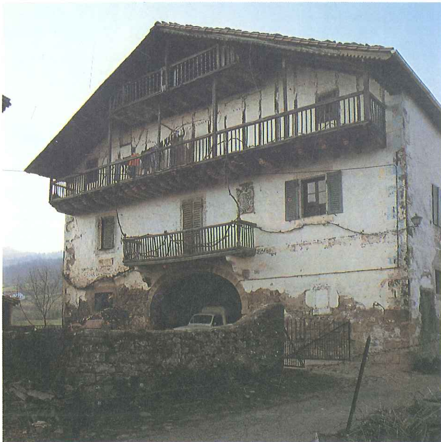
DOLAREA. Urrasun, Navarra. Casa de labranza con sus blasones en fachada, arco carpa nel formando zaguán, balcones de madera volados y cumplido alero.
