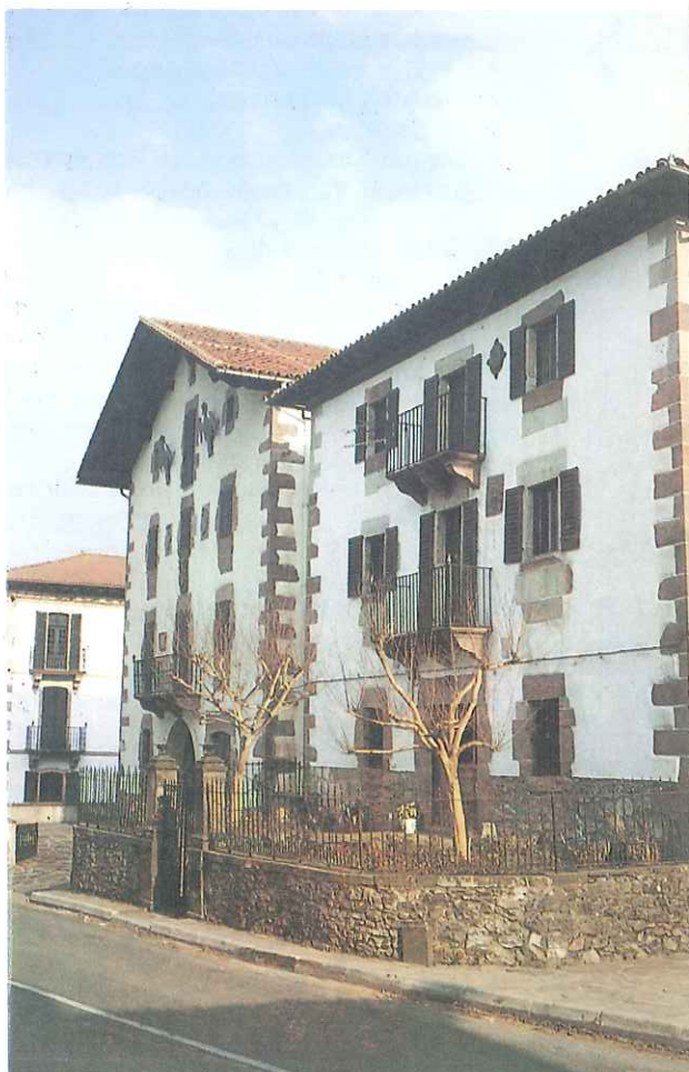
ARECHEA. Casa solar de Irurita, en el valle del Baztán, Navarra.
