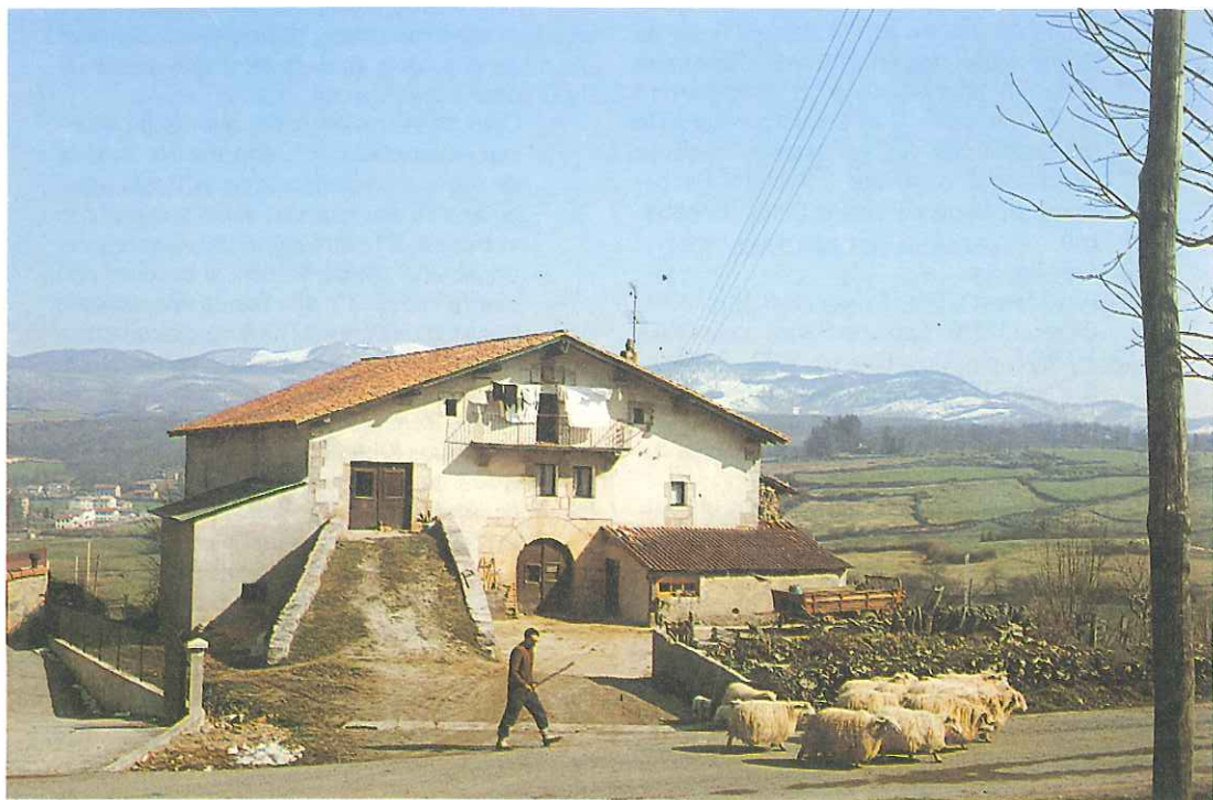
BORDE. Caserío del municipio rural de Alli, Navarra. Sacrificada parte de la fachada principal para proveer de rampa al desván.
