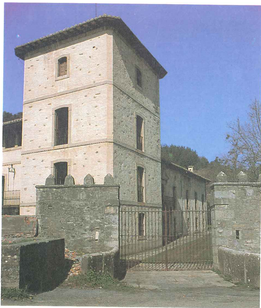
ACHA. Solar y palacio de linajuda familia. Sólida construcción de sillares de piedra caliza en la fachada principal. Respaldiza, valle de Ayala, Alava.
