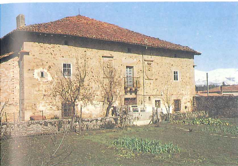
ARRIETA. Palacio ubicado en Ozaeta, Alava. De planta cuadrada, cubierta a cuatro aguas con fachadas de piedra. Ostenta hermoso escudo barroco.
